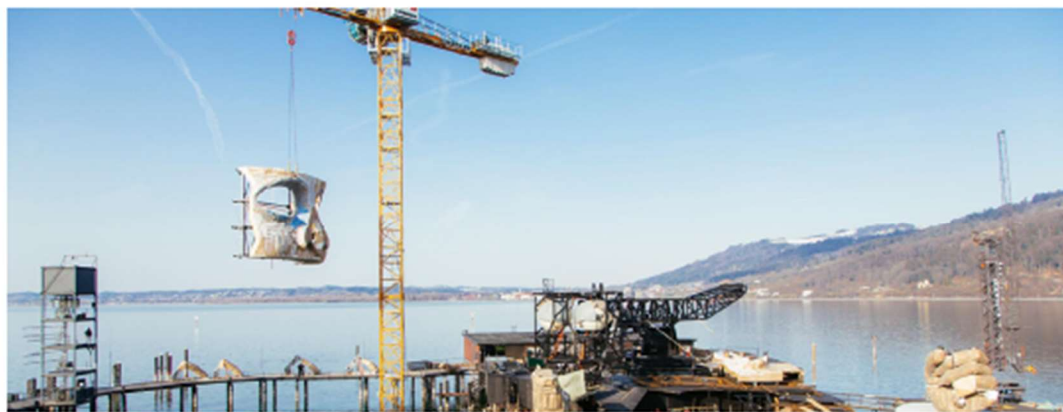
Ein weiteres Projekt der Firma Biedenkapp Stahlbau GmbH: das Bühnenbild der Operninszenierung „Rigoletto“ (siehe Titelbild). Alle Teile des Kopfes sind beweglich und bestehen aus dem Inneren Stahlfachwerk, dem unteren Stahlfachwerk für den Mund und dem Kaschurfachwerk. Für diese anspruchsvolle Sonderkonstruktion erhielt das Unternehmen 2019 den renommierten Stahlbaupreis. Foto: Biedenkapp Stahlbau GmbH
